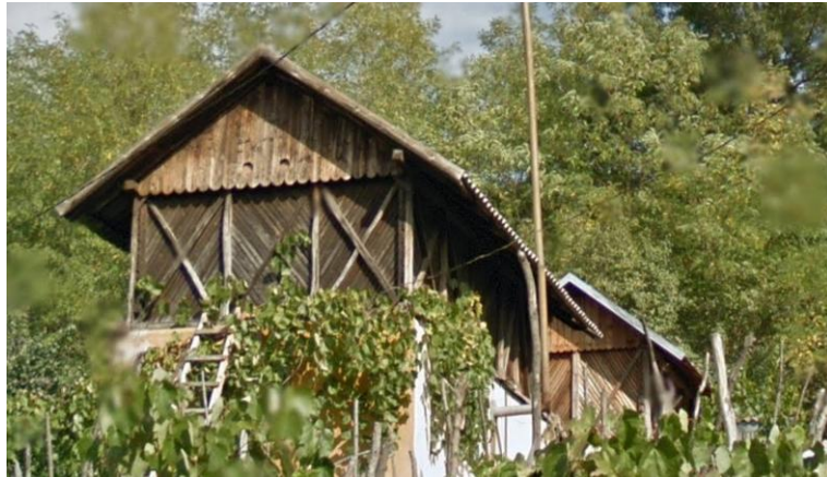
Str. Armoniei pe dreapta anexe din lemn
